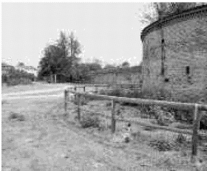
Uno scorcio del parco: i lavori di sistemazione sono quasi finiti
