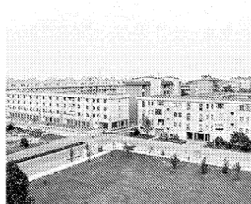
L'intervento alla Piastra di Lunetta
